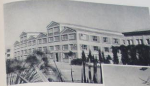
GRUPOS DE TALLERES, AL LADO DE OFICINAS, GENERALES Y VESTIARIOS.
